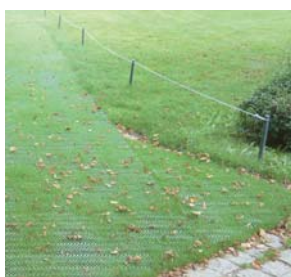
Nach 10 Tagen: Die Grasnarbe wächst durch die Gitterstruktur.
